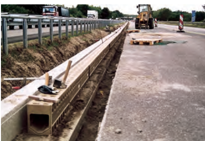
Fase di posa di RD 300 a lato autostrada
