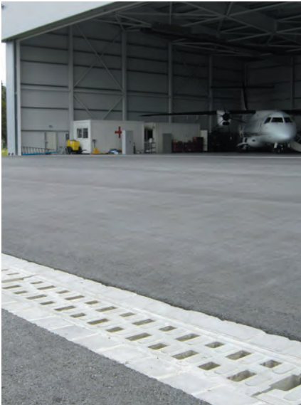
Monoblock posato all'esterno di un hangar aeroportuale
