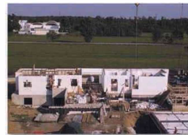
Ville in costruzione con tecnica canadese per ottenere il fabbricato certificato in Classe A
