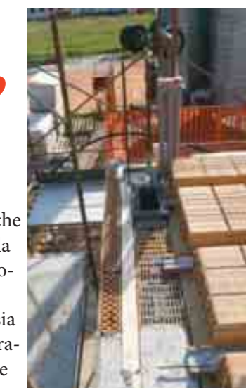
Muratura perimetrale a cassetta
