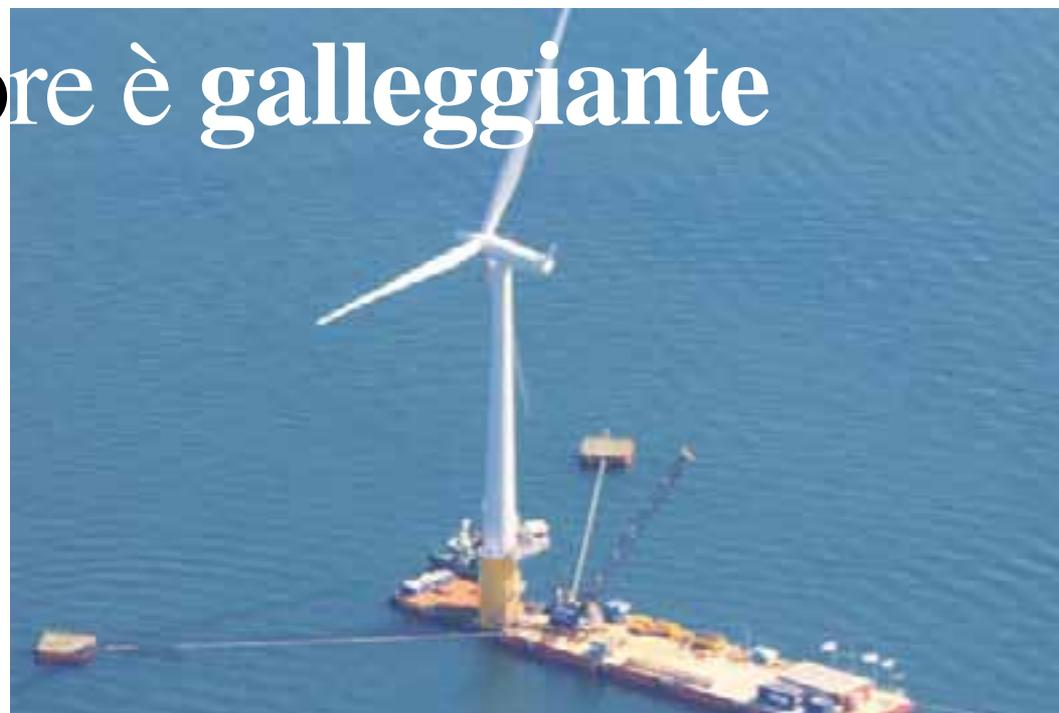
d'acciaio, ed è installabile in acque che vanno dai 120 ai 700 metri di profondità, estendendo enormemente le possibilità di impiego (l'eolico offshore convenzionale si ferma ad acque profonde al massimo 70 metri), l'ancoraggio con i cavi lo rende inoltre meno sensibile alle forti correnti. Hywind è quindi posizionabile anche a grande distanza dalla costa, con un miglior rendimento (più lontano dalla costa il vento è più forte e regolare) e minimizz-
