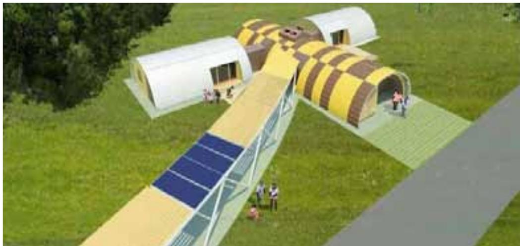
chiedono velocità costruttiva. Sullo scheletro metallico si fissano i pannelli Elycop e la sua conformazione a carena ottimizza energeticamente il rapporto tra volume interno e superfici disperdenti.
