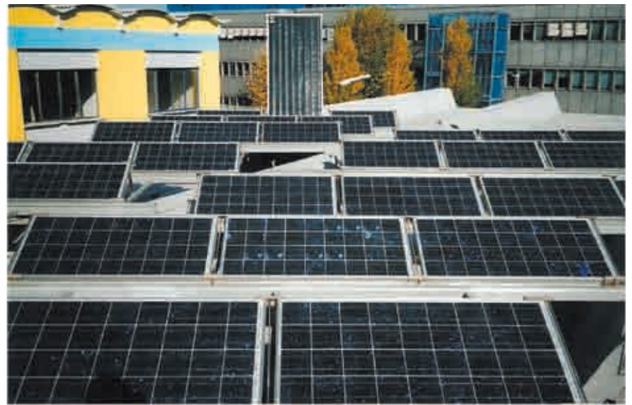
Pannelli fotovoltaici sul tetto
