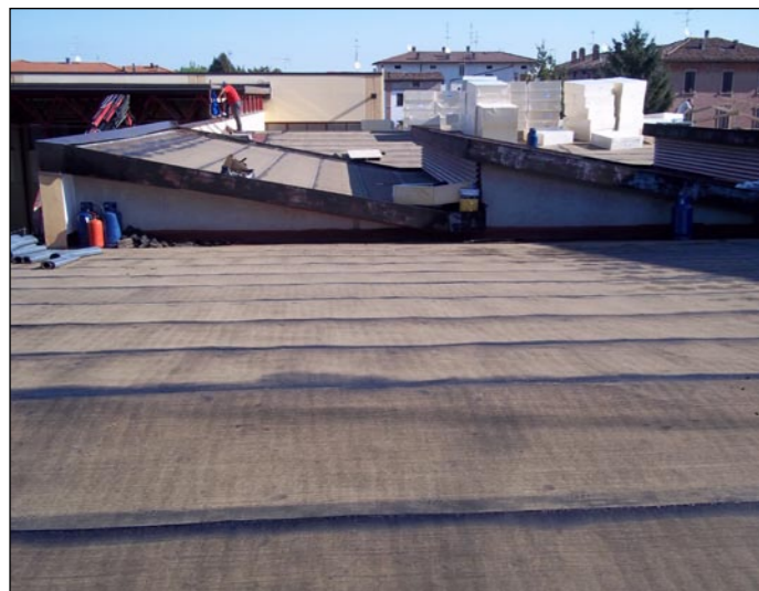
La barriera al vapore posata
