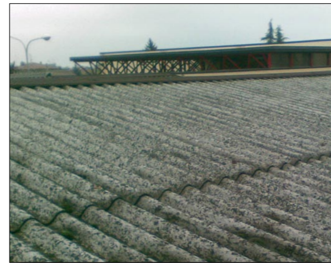
Gli shed ricoperti con fibrocemento
