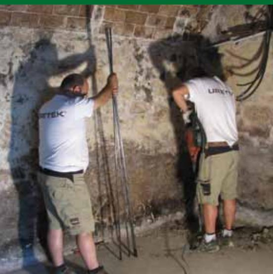
Estrazione del tubo durante l'iniezione: metodo "colonnare".
