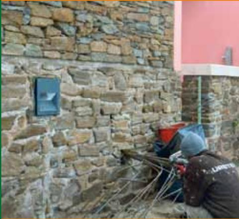
**Posizionamento dei tubi d'iniezione della resina** orizzontalmente, attraverso il muro di sostegno del terrapieno della piscina.
