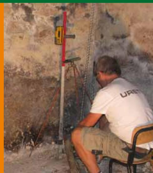
Controllo laser millimetrico.
