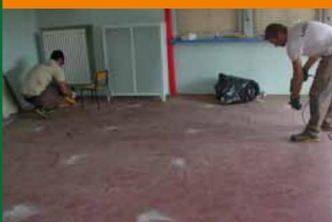
**Iniezioni di resina espandente dal solaio del piano terra.**
