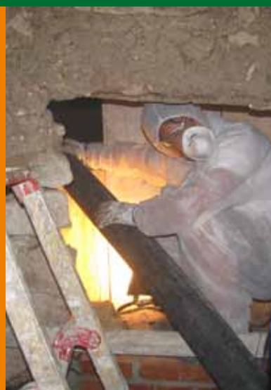
Tubi d'iniezione attraversano la fondazione continua.
