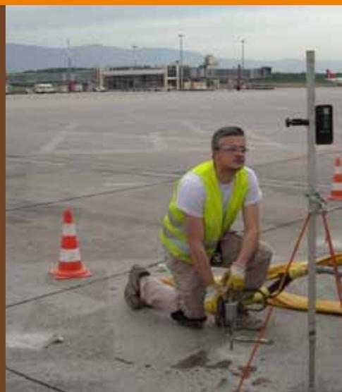
Controllo del ricevitore laser durante l'iniezione.
