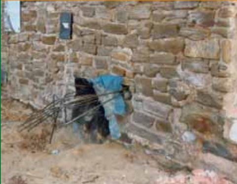
**I tubi d'iniezione posati** all'interno della cavità con diverse inclinazioni per una migliore distribuzione della resina.
