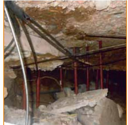
**Particolare dei tubi di iniezione della resina** all'interno della cavità.
