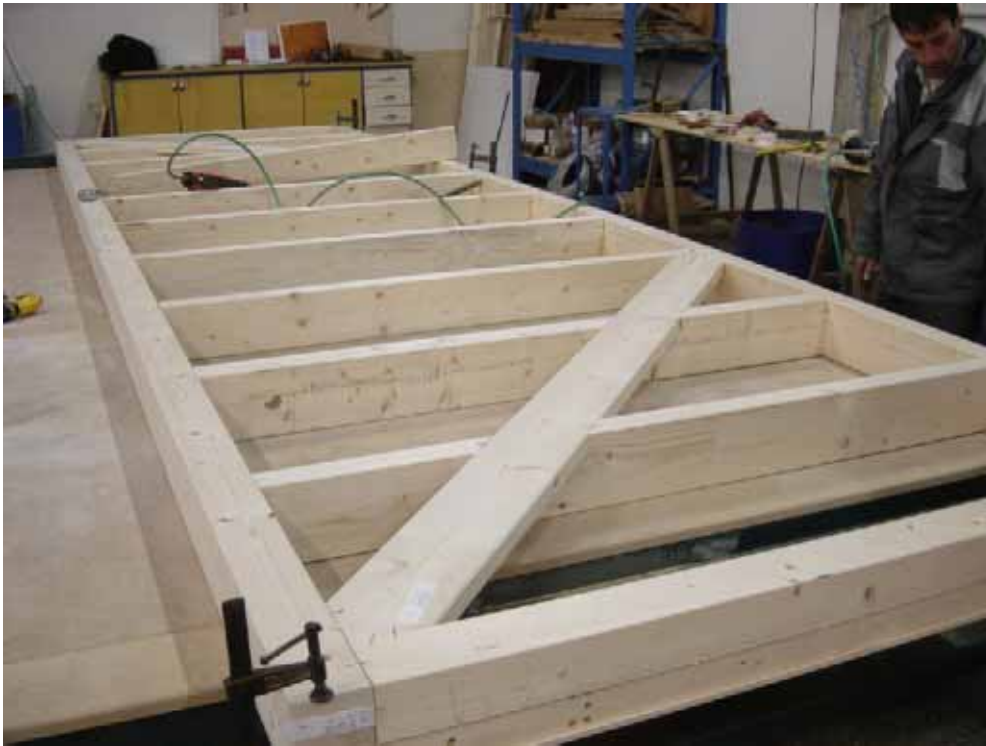
Tipologia a telaio
