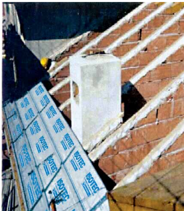
Posa di ISOTEC® su struttura continua in laterocemento
