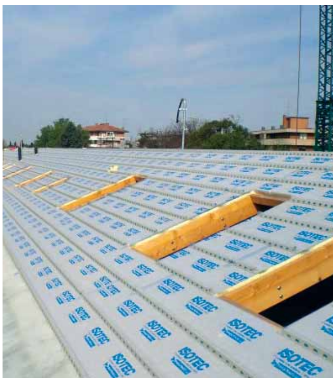
Posa di ISOTEC® su struttura continua in laterocemento
