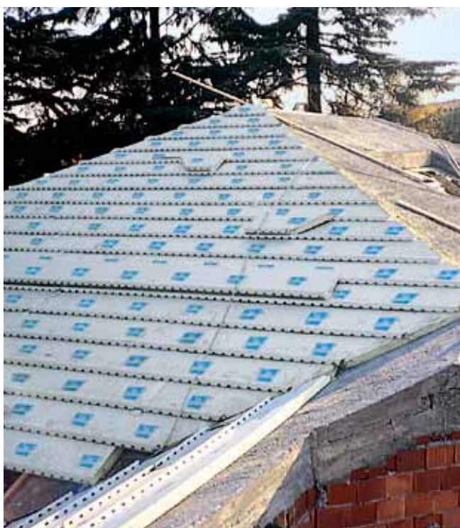
Posa di ISOTEC® su struttura continua in laterocemento
