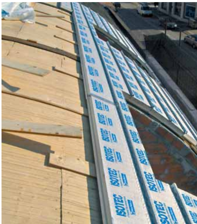
Posa di ISOTEC® su struttura continua in legno
