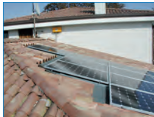
TIPOLOGIA SPECIFICA 1, caso A (tetto a falda con moduli che coprono una parte della copertura)
